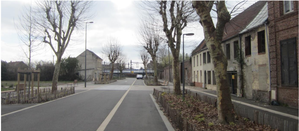
Portion rénovée de la rue de l'Horlogerie desservant les zones A et B. Les alignements d'arbres sont à conserver
