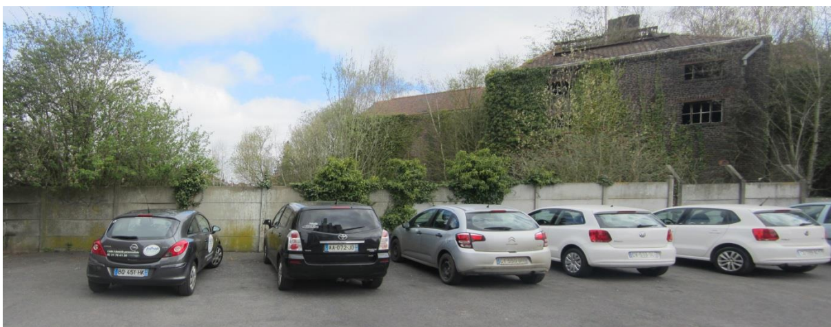
L'accès potentiel de la zone A depuis le parking de la rue A. Outrebon – la zone est en friche et possède d'anciens bâtiments à pouvant être démolis
