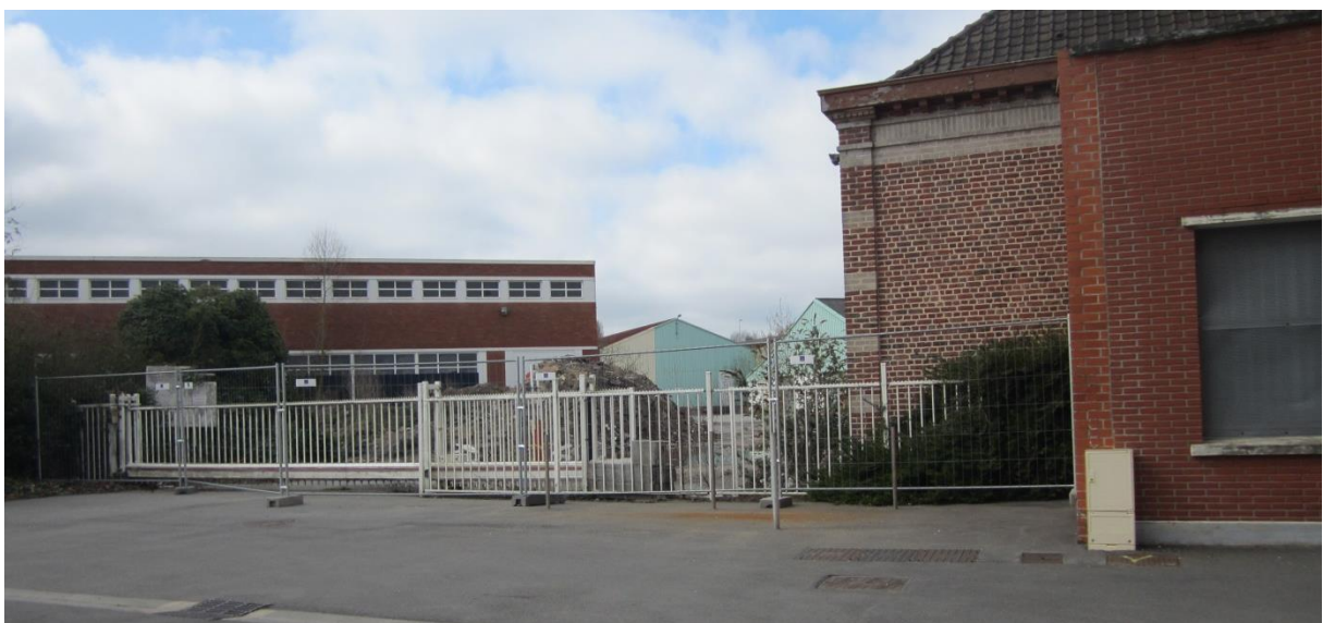
Les bâtiments existants, à conserver et à démolir de la zone B
