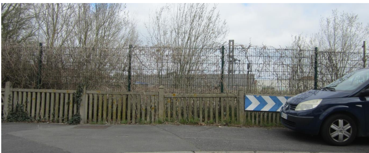
Les abords du site depuis la de Verquin au sud. La zone est en friche et la voie ferrée est en partie visible
